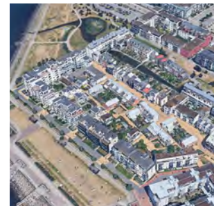
OBR. 26 Västra Hamnen, Malmö; zdroj: Google Earth
